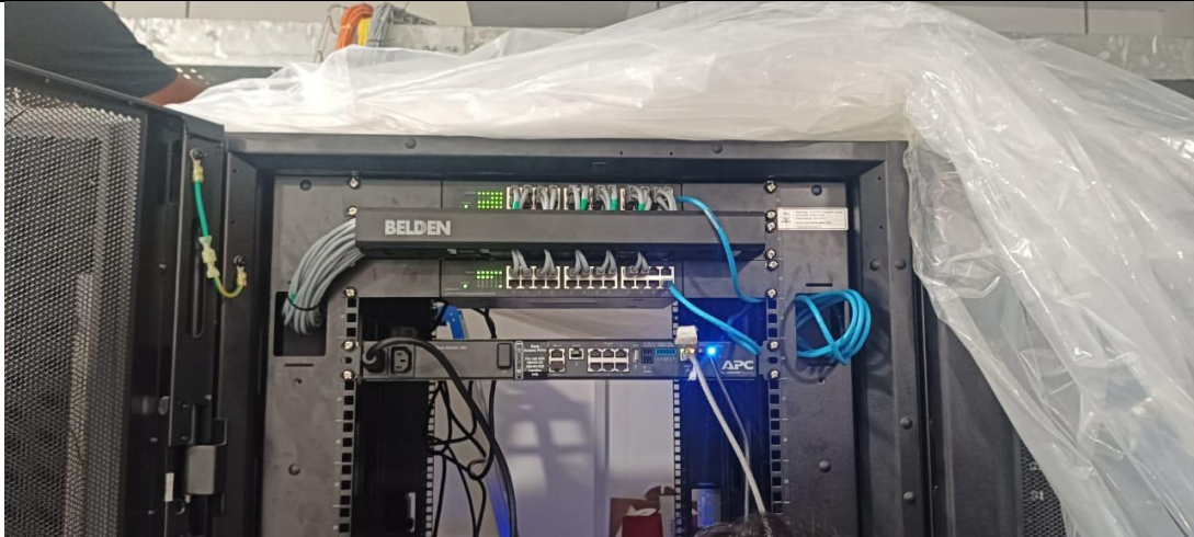
Proses Discovery Sensor TH, Rack PDU untuk DCIM
